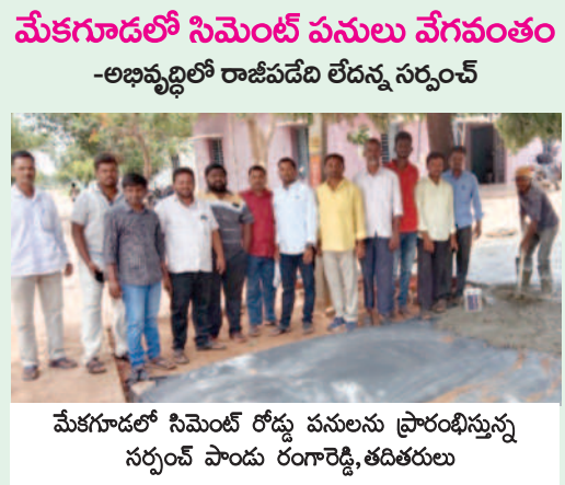
మేకగూడలో సిమెంట్ రోడ్డు పనులను ప్రారంభిస్తున్న నర్సం పాండు రంగారెడ్డి,తదితరులు
